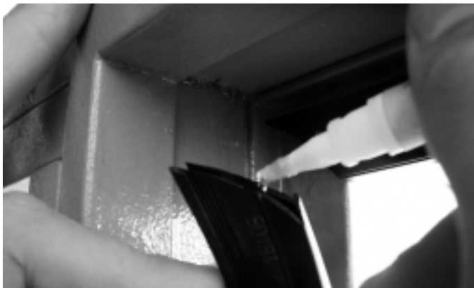
Abb. 14 Gehrungsecken verkleben Fig. 14 Gehrungsecken verkleben
