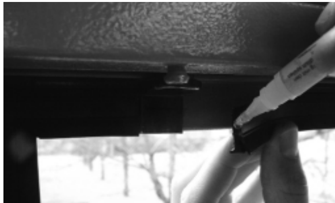
Abb. 15 Verkleben mit Belüftungswinkel Fig. 15 Verkleben mit Belüftungswinkel
