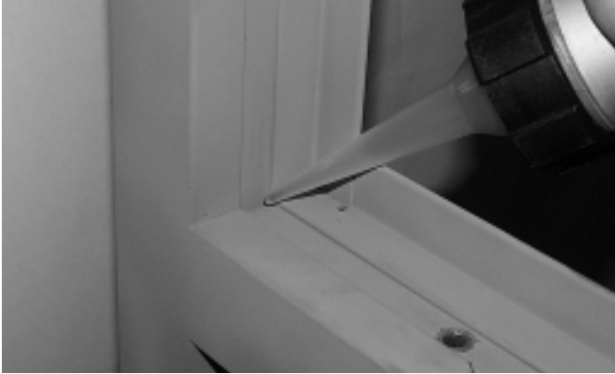
Abb. 11 Abdichten Ecken- und T-Stoss
