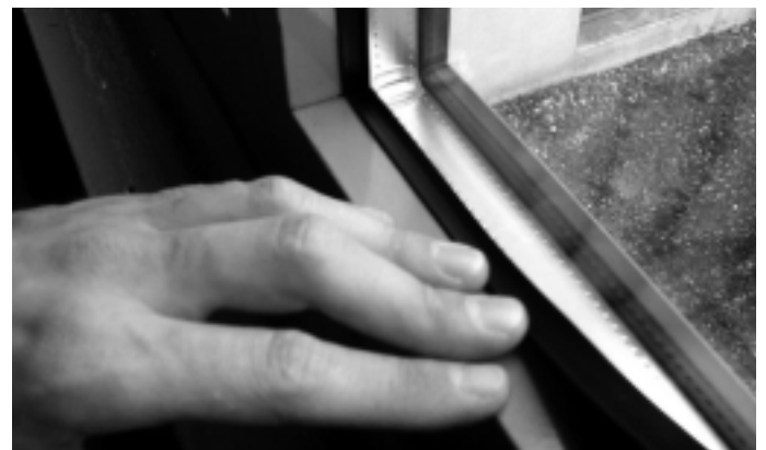
Abb. 20 Einbau der Innendichtung Fig. 20 Einbau der Innendichtung
